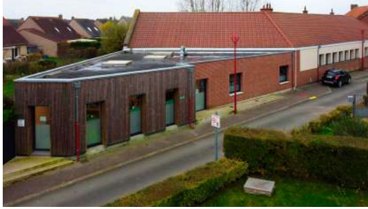
KILLEM - Rénovation et extension de l'école maternelle 91 610 €
